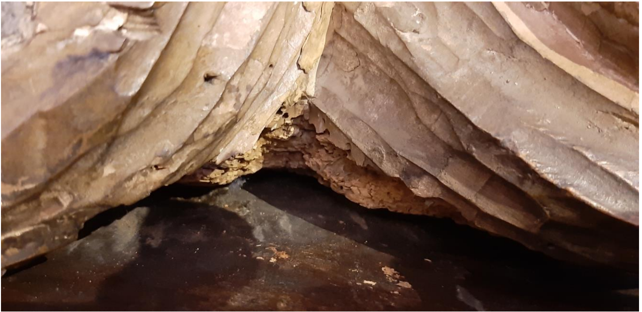
Attacco xilofago attivo con deposito di rosime
