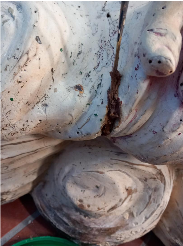
Stuccatura delle lesioni strutturali con araldite
